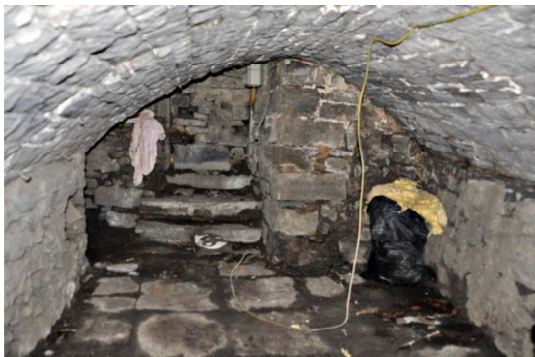
La cave voûtée avec son escalier qui donnait à front de rue
